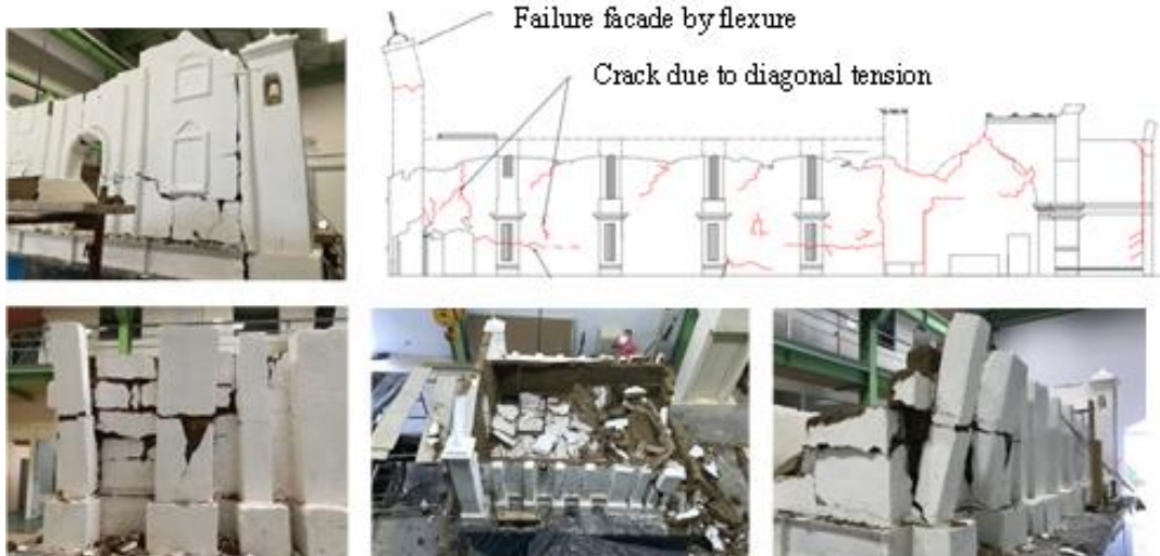
Daños en la Iglesia de San Raymundo
